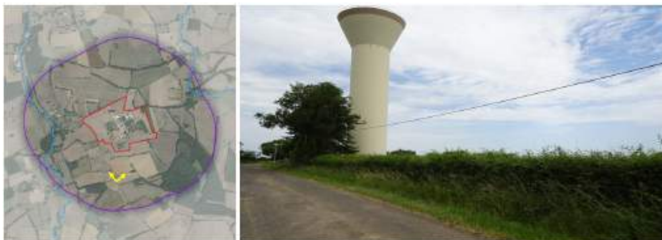
Figure 181 : Photographie du principal bâtiment à caractère industriel de l’AEI, à savoir un château d’eau (Crédit photo : NCA Environnement)
