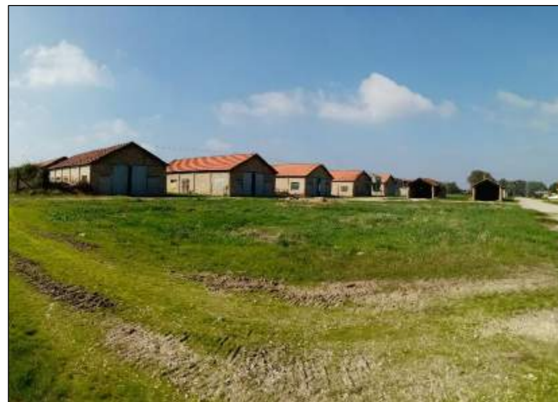
Prise de vue D : Vue en direction de l’ouest depuis la partie sud
