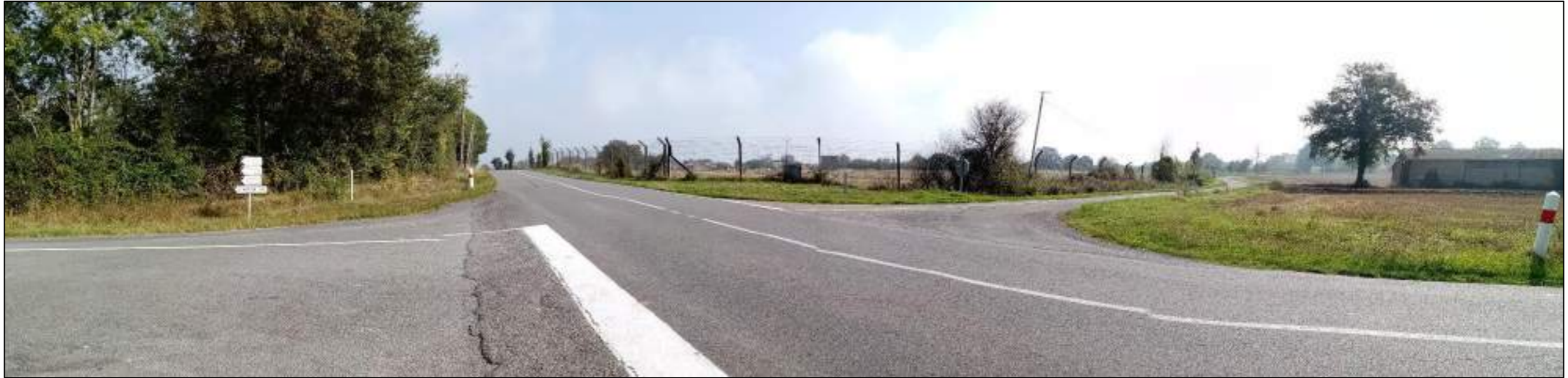
Vue 1' : Vue panoramique en direction du nord depuis l'entrée du site
