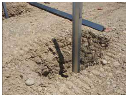
Figure 25 : Types de fondation - pieux battus (Source : Guide MEDDTL 2011 – NCA, 2015)
