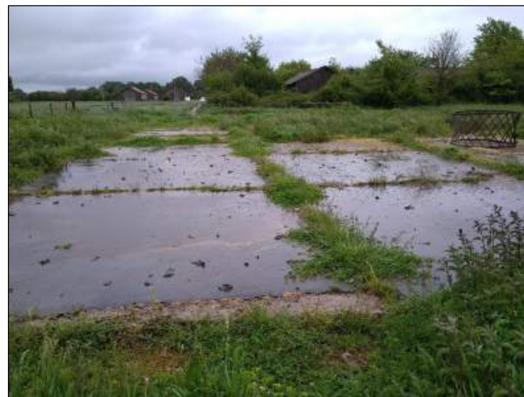
Figure 96 : Plateforme en béton et bâtiments, photo prise sur site, © NCA Environnement juin 2021
