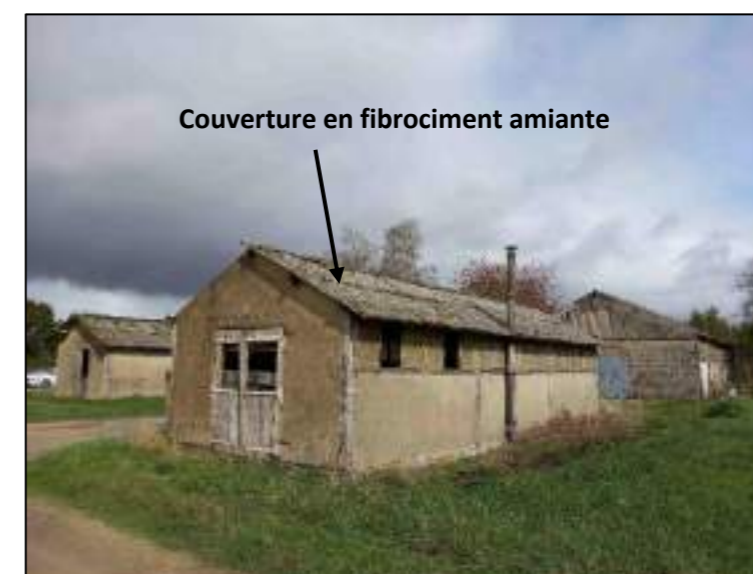
Figure 51 : Couverture en fibrociment amiante (Source : AMARENCO)
