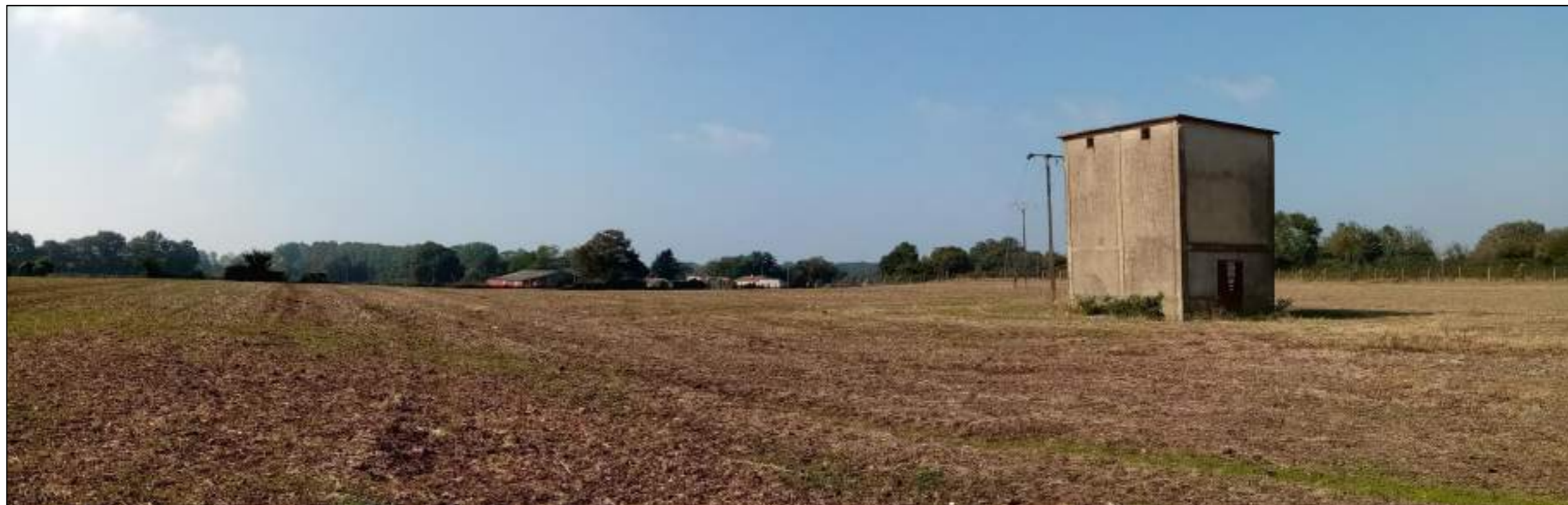
Vue 4 : Vue panoramique en direction du nord depuis la partie nord-ouest du site
