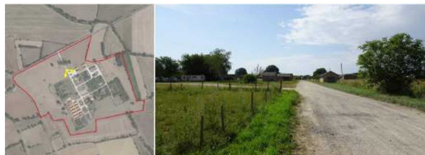
Figure 185 : Photographie de l'axe viaire interne au site d'étude et de quelques constructions militaires datant de 1938 (Crédit photo : NCA Environnement)
