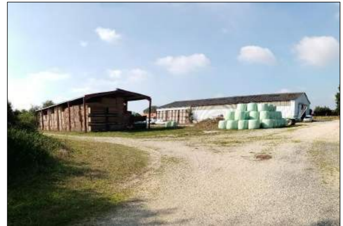
Prise de vue H : Vue en direction du nord-ouest depuis la partie centre-est du site
