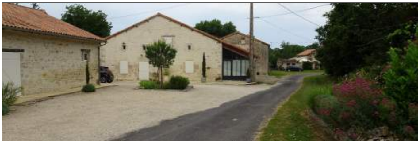
Figure 204 : Photographie du hameau de proximité dit de la Brunetière, présent à l’ouest du projet (Source : NCA Environnement)
