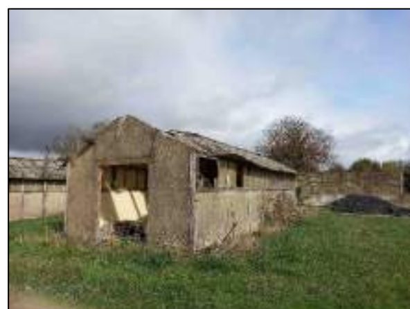
Figure 52 : Plaques amiantées sous tuiles plates (Source : AMARENCO)
