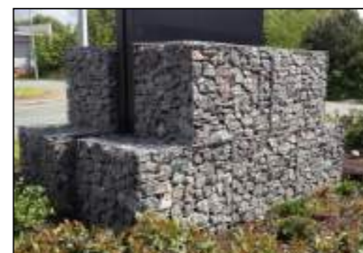
Figure 27 : Fixation par des gabions (Source : TCS Geotechnics)
