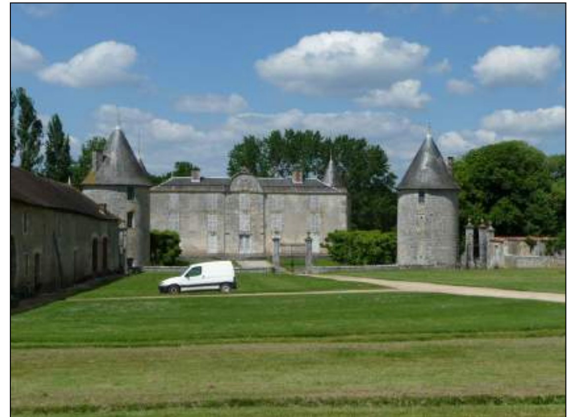
Figure 143 : Photographie du château de Saint-Martin-l’Ars (Source : https://www.saint-martin-lars.fr )
